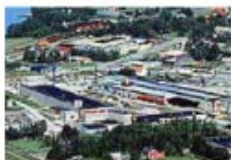
SCF Betongelement AB i Strömsund
