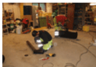
Tillverkning av muffar till fjärrvärmerör
