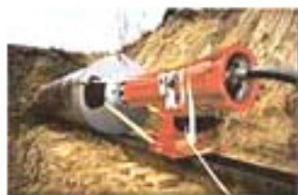
Rammning stålrör genom vägbank
